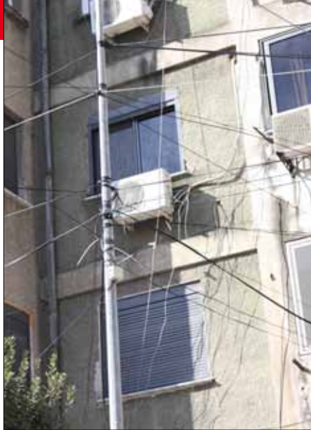
Kabliranje na ulicama Draču po sistemu "zaveži za što možeš", pa makar to bio i rasvjetni stup
